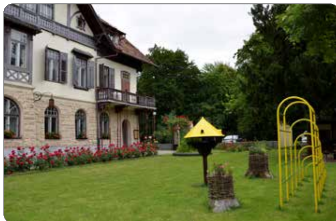
Pred obnovo balkona
